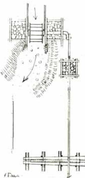
Till höger ser vi vattenhjulet mellan två stenkistor. Som hjulstock används en granstock med rotdel (revstaken). I denna är sågstängen fästad. Den är ledad såväl horisontellt som vertikalt och tredelad. En del går genom en stenkista för stagning av stängen. Till vänster upplagd på två stockar en stock färdig för sågning.
